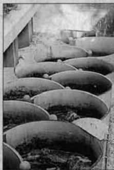
Hilft Lachsen auf dem Weg zum Laichplatz: Der Fischpass neben dem Wasserrad.
