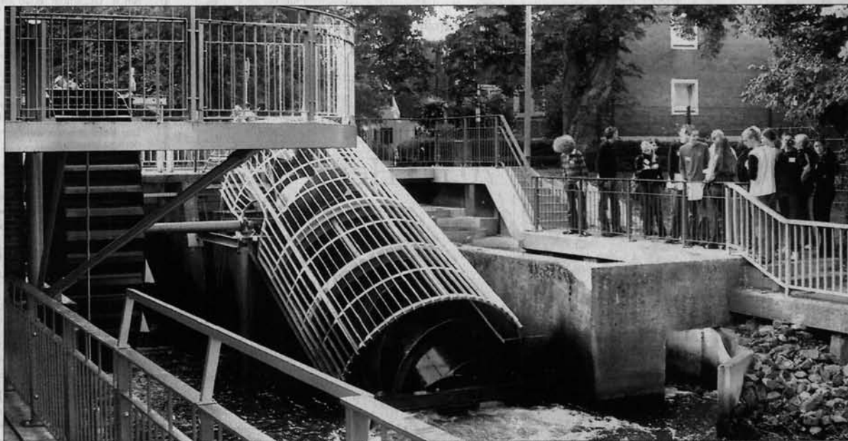
Das Wasserrad und die Wasserschnecke nach dem Archimedischen Prinzip an der Wassermühle in Friesoythe. Sie sind ein gutes Beispiel für eine lokale Erzeugung regenerativer Energien aus Wasserkraft. Ein Fischpass neben der Wasserschnecke sorgt dafür, dass das Bauwerk kein Hindernis auf dem Weg zu den Laichplätzen der Fische bildet. BILDER: KEVIN KRETSCHMER
